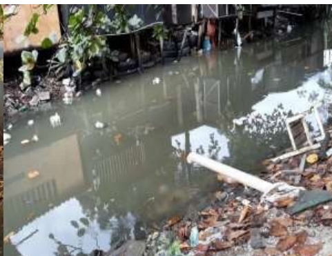
Esgoto doméstico. Fonte: Novo Milênio
